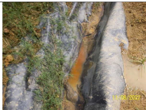
Foto 6. Recorrido canal de aguas lluvias con lixiviados
