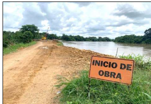
Figura 60. Puente San Pelayo
