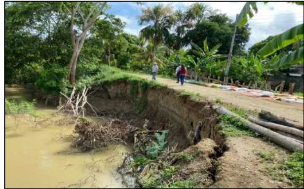
Figura 29. Realización de inspecciones terrestres
