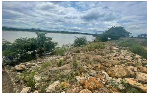
Figura 14. Enrocado en la vereda Carrizola, municipio de Tierralta.
