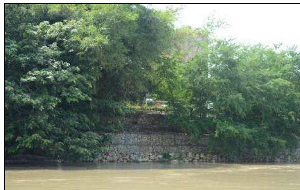
Figura 21. Obra de infraestructura realizada por la CVS en la ronda Norte del municipio de Montería, como medida de adaptación.
