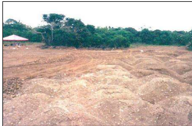
Figura 17. Adecuación de tierras - relleno de zonas bajas.
