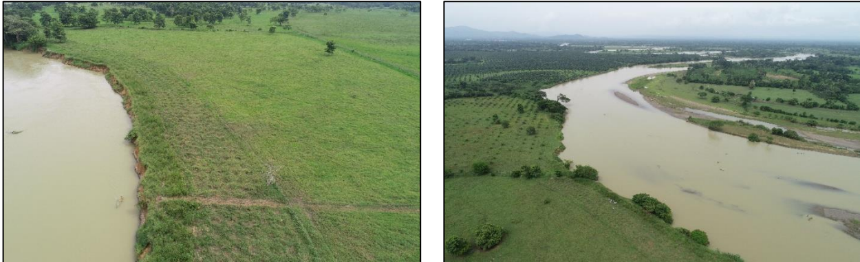
Figura 17. Establecimiento de cobertura vegetal en el río Sinú, municipio de Valencia.
