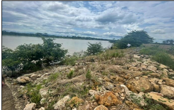
Figura 16. Enrocado en la vereda Carrizola, municipio de Tierralta.
