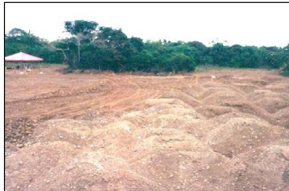
Figura 19. Adecuación de tierras - relleno de zonas bajas.
