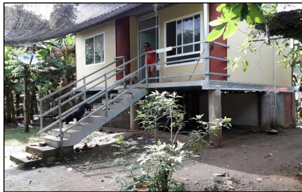
Figura 22. Infraestructura adaptada en San Bernardo del Viento. Tipo de construcción a prueba de inundaciones.
