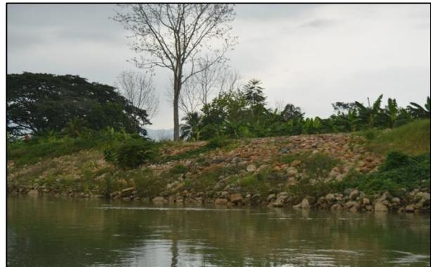
**Figura 16. Enrocado en la vereda Carrizola, municipio de Tierralta.**
