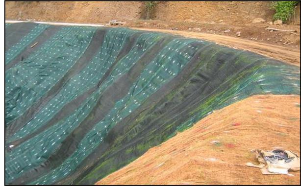
**Figura 10. Mantos permanentes para control de erosión.**
