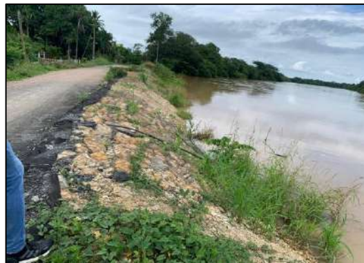
Figura 62. Puente San Pelayo
