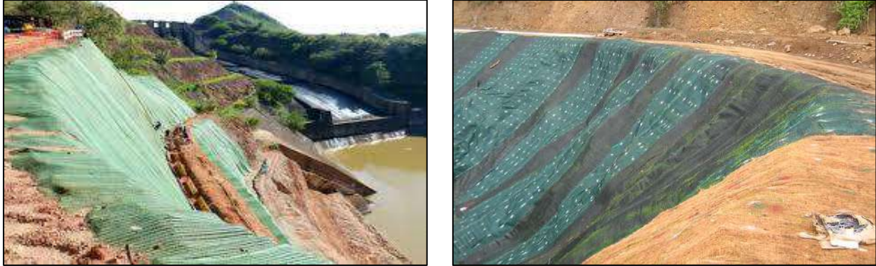
Figura 16. Mantos permanentes para control de erosión.
