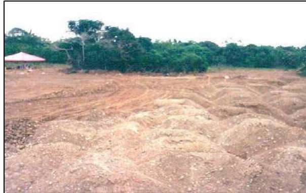
Figura 20. Adecuación de tierras - relleno de zonas bajas.
