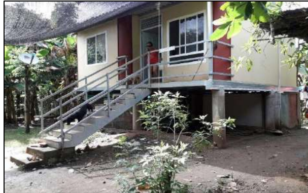
Figura 23. Infraestructura adaptada en San Bernardo del Viento. Tipo de construcción a prueba de inundaciones.
