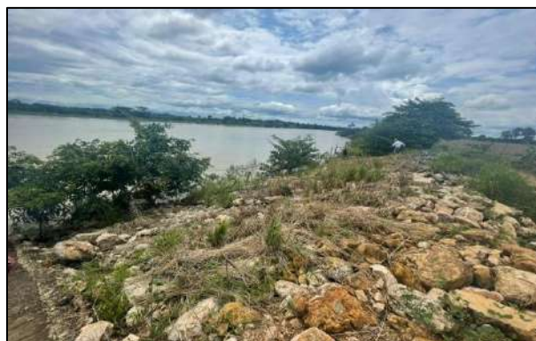
Figura 17. Enrocado en la vereda Carrizola, municipio de Tierralta.
