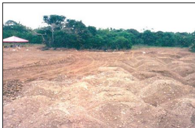
Figura 18. Adecuación de tierras - relleno de zonas bajas.
