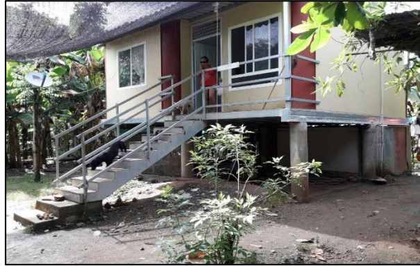
Figura 21. Infraestructura adaptada en San Bernardo del Viento. Tipo de construcción a prueba de inundaciones.
