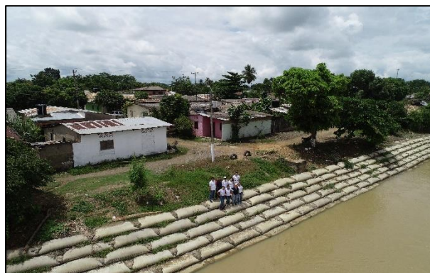
Figura 29. Realización de sobrevuelos e inspecciones terrestres
