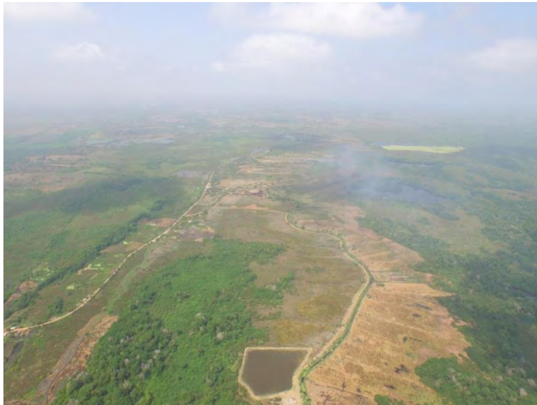
Fotografía 14. Tramo intermedio del Caño Sicará
