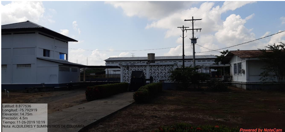
Figura 18. Instalaciones físicas de Alquileres y Suministros de Colombia.
