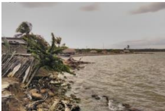
Vista general, punto crítico de erosión costera
