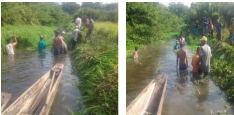
Rehabilitación del caño cantarillo actividad que la realiza la comunidad corporación CVS
