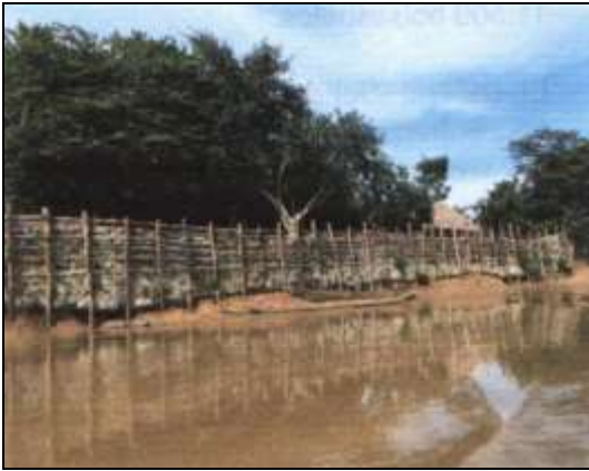
Seguimiento a obras (tablestacado provisional en el corregimiento de Seheve, municipio de Ayapel)
