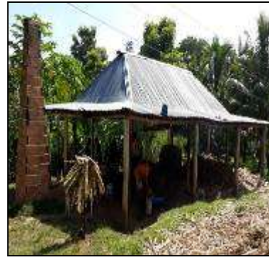
Infraestructura del proceso.
