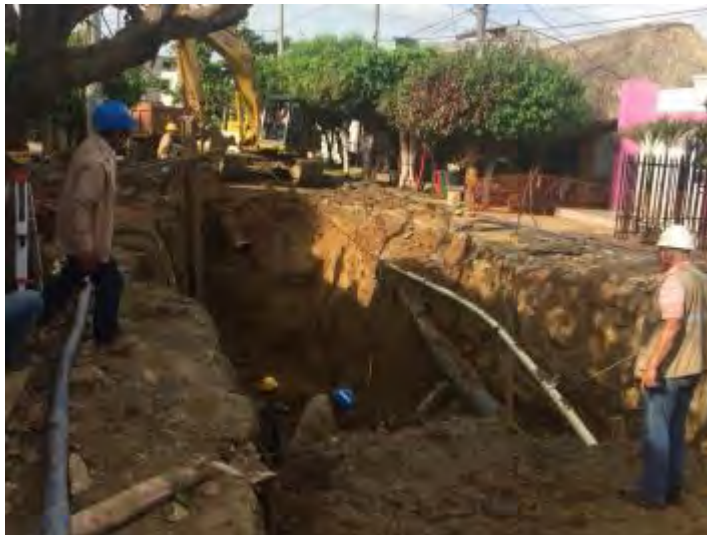
Colector intervenido denominado "Arenal Centro" donde se evidenciaron mayores cantidades de excavación y relleno durante el proyecto.
