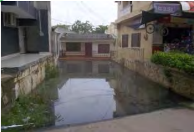
Zona aledaña al colector intervenido denominado "Arenal Centro".
