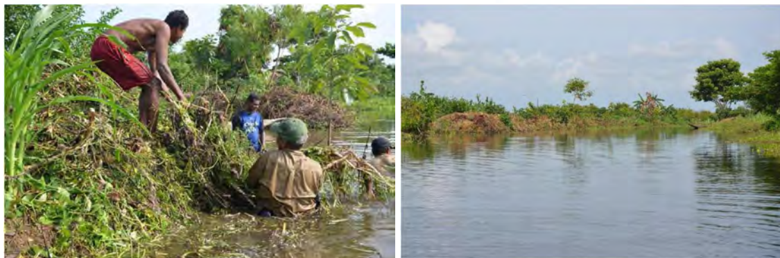
Actividades realizadas para la limpieza de canales en el área del proyecto.
