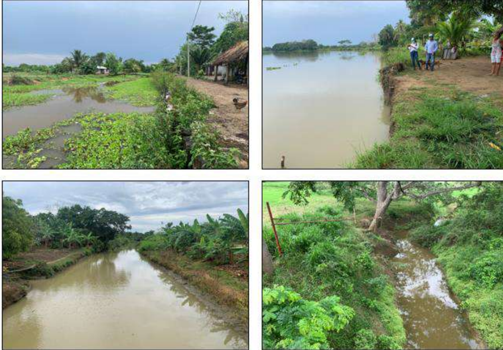
Ilustración 115. Registro fotográfico de las actividades de seguimiento y monitoreo de los niveles de los ríos Sinú, San Jorge y Canalete, la Quebrada Uré, Caño Grande y Caño Sicará. Fuente: Grupo de Gestión del Riesgo – GGR CVS, 2023.
