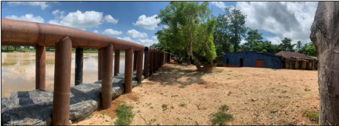
Registro fotográfico Obra de mitigación y protección de la margen derecha del río San Jorge, en el corregimiento Marralú, municipio de Ayapel. Fuente: Grupo de Gestión del Riesgo – GGR CVS, 2023.
