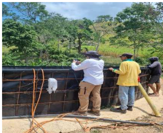
Ilustración 33. Seguimiento PUEAA aprobado Estación Piscícola Chinú. Fuente: Equipo SGA, 2023
