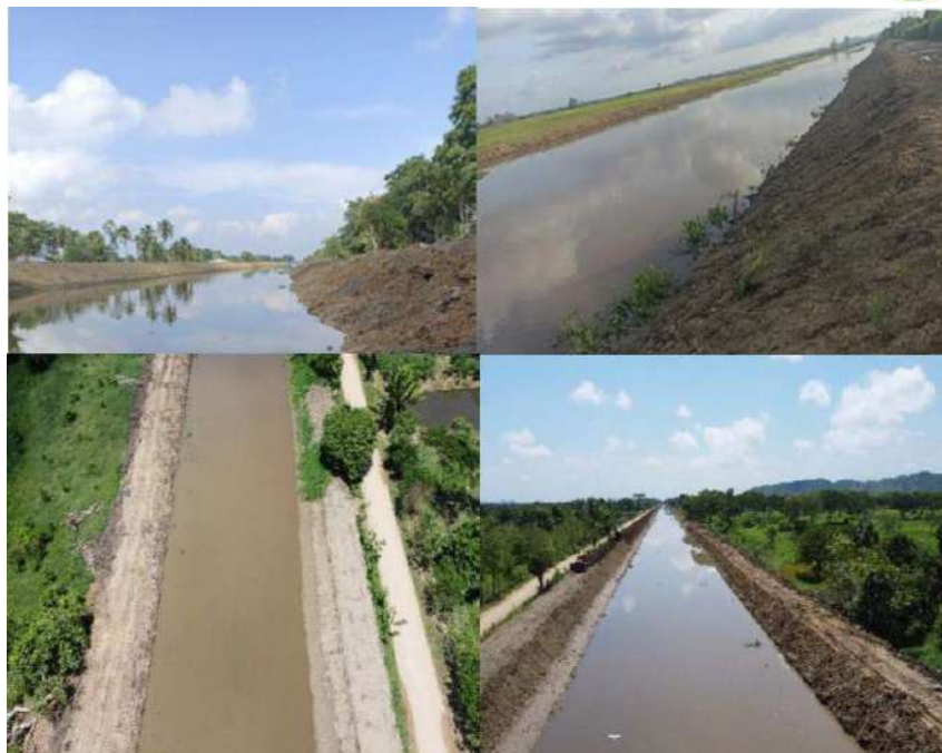
Ilustración 19. Ampliación de la Sección y conformación de terraplenes. Fuente: CVS, 2023
