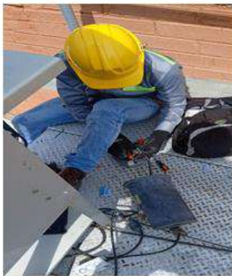
Mantenimiento equipos SVCA
