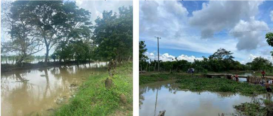
Ilustración 15. Rocería de zonas aledañas al caño intervenido vs Remoción manual de material sobrenadante acumulado en caño intervenido. Fuente: CVS, 2023
