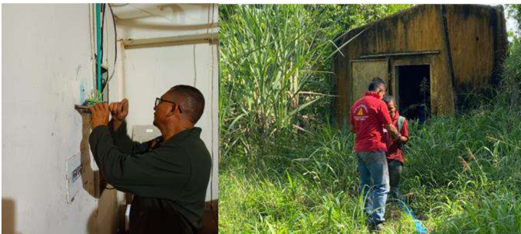
Mantenimientos eléctricos en la Estación Piscícola.
