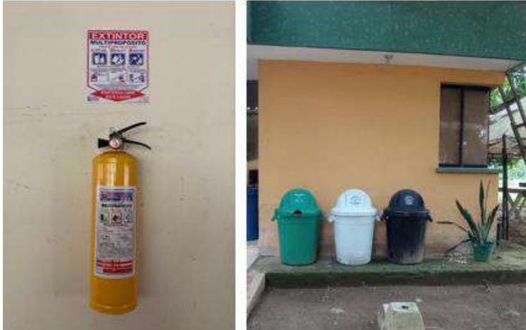
Instalación y ubicación de extintor y punto ecológico en la Estación Piscícola.
