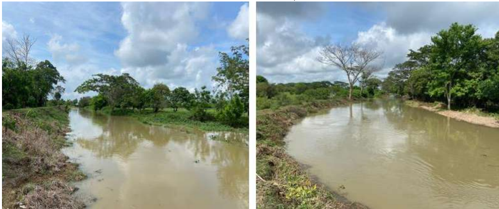
Ilustración 16. Tramo de caño intervenido posterior a labores de limpieza y rocería. Fuente: CVS, 2023
