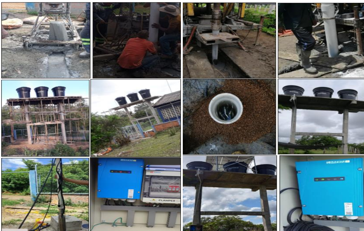
Ilustración 150. Construcción de pozo, torre e instalación de equipo de bombeo y eléctricos. Vereda Arenal – Purísima (Izq) y Vereda Morrocuya – San Carlos (Der). Fuente: CONSORCIO POZOS, 2022.
