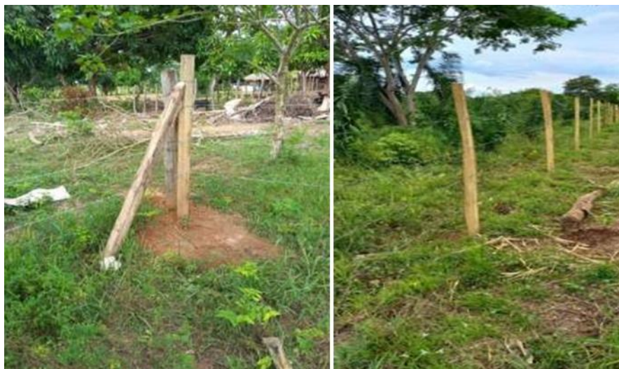
Ilustración 63. Labores de aislamiento. Fuente: Equipo técnico SPA, 2022
