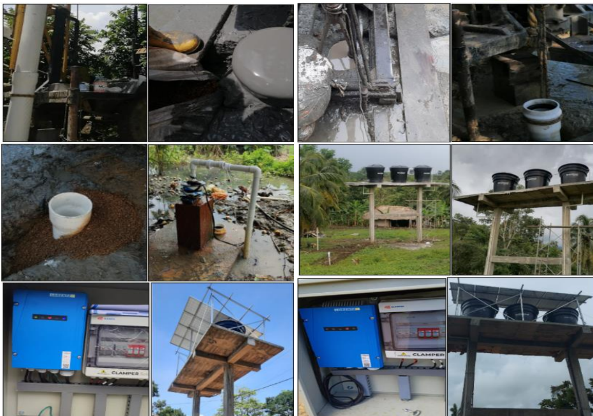
Ilustración 151. Construcción de pozo, torre e instalación de equipo de bombeo y eléctricos. Corregimiento Trementino – Cotorra (Izq) y Vereda Parcelas De Viejo Loco – CANALETE (Der). Fuente: CONSORCIO POZOS, 2022.
