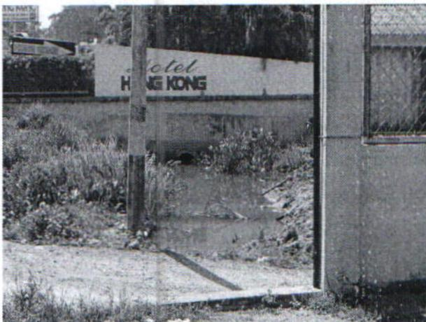
Foto N° 5. Se puede observar vertimiento aguas residuales al canal de aguas lluvias existente.
