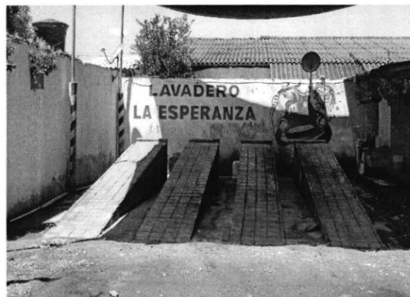
Foto N° 2. Se puede observar cárcamos zona de lavado.
