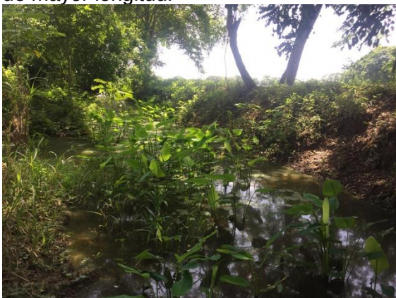
Foto 7. Unión del terraplén corto, con el de mayor longitud.
