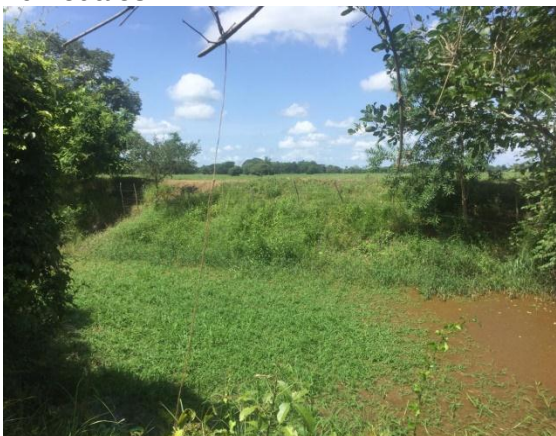
Foto 11. Terraplén paralelo al canal con presunto mantenimiento, Finca Santa Marta.
