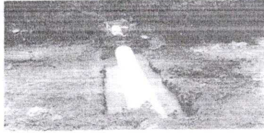
Construcción Bypass tubería de entrada a sedimentador PTRA
