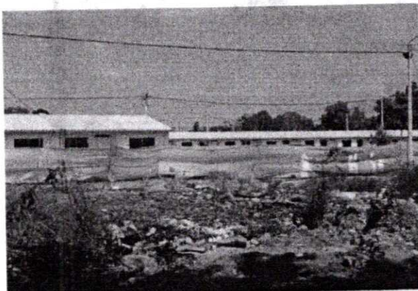
Imagen: 3 Frente de las nuevas viviendas
