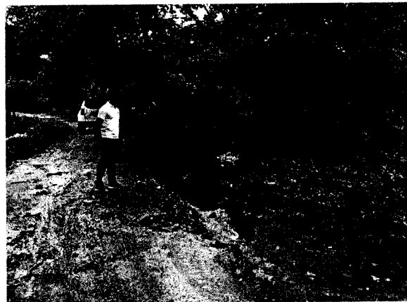
Foto N°4. Fuerte erosión en cabeceras de alcantarilla circular tipo husillo, por aguas de escorrentías.
