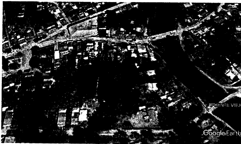
Imagen1. Tramo entre los dos puentes vehiculares, en el círculo el sitio donde presuntamente se reduciría el cauce.
