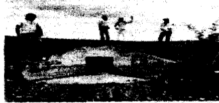
Foto N°3 y 4. Alcantarilla cuadrada de 1x1 m sobre la vía Montería-Lorica. Se observa construcción de alcantarilla en la segunda calzada de la vía Montería - Lorica. Coordenada punto 2
