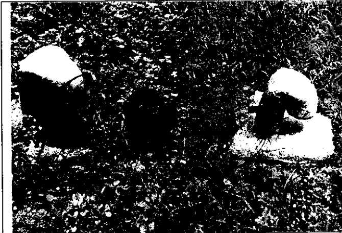
Fig. N° 5 Chimeneas de desfogue quemadas.
