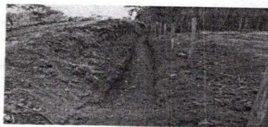
Fotografía 2. Canal lateral al terraplén
