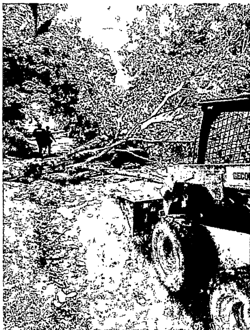
Maquinaria retirando troncos
