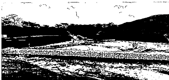
Fotografía 4. Filtros de fondo para recolección y conducción de lixiviados.
