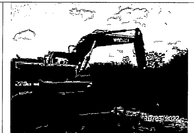
Foto 11. Retroexcavadora usada para los apiques.
