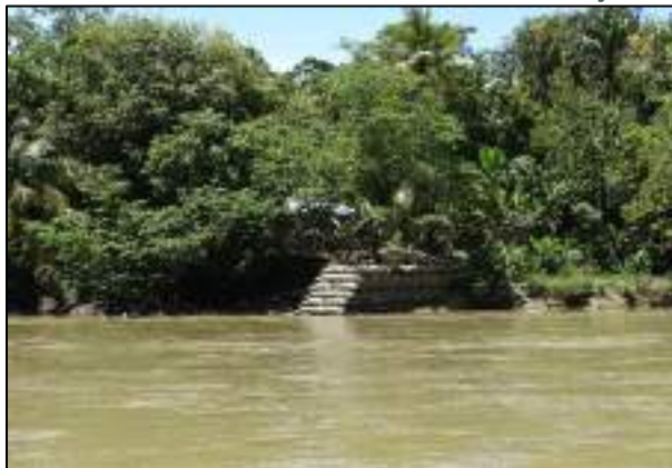
Figura 32. Puente Valencia, municipio de Tierralta Fuente: Equipo técnico, 2024
