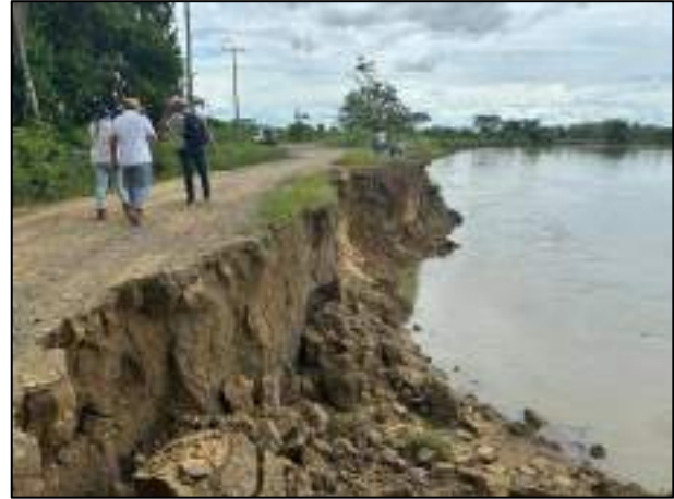
Figura 26. Realización de inspecciones terrestres
