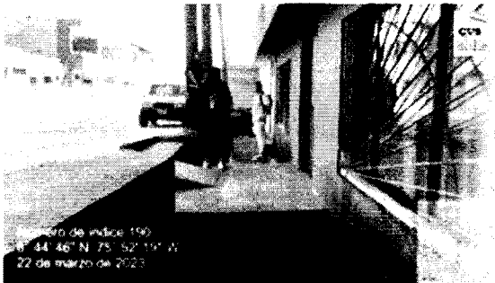
Foto 3. Vivienda afectada por el taponamiento del drenaje
