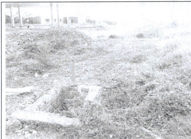
Foto 3. Cajas de Inspección de la alcantarilla de menor sección construida en el canal de drenaje.
