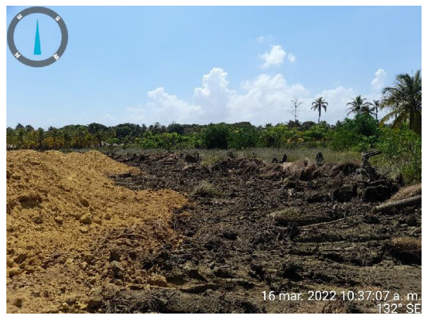
Imagen 6. Véase actividades de tala de manglar, remoción de cobertura y relleno del suelo
