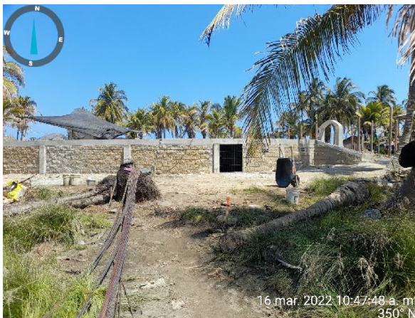
Imagen 1. Véase construcción de la piscina en zonas de playa
