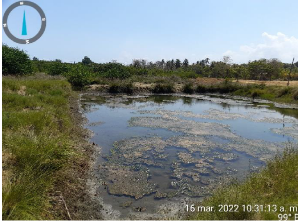
Imagen 8. Véase actividades de excavación de pozo artificial en zonas de manglar.
