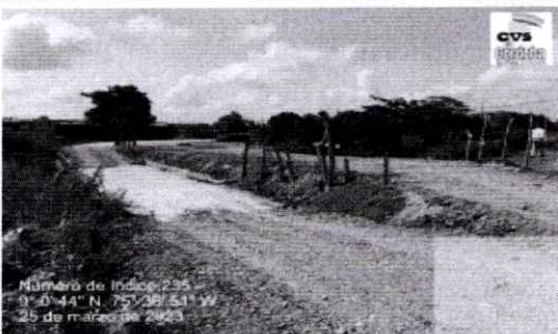
Foto 3. Obra antrópica puente de Boca de Catabre
