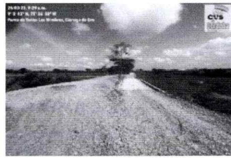
Foto 8. Obra antrópica puente de Boca de Catabre
