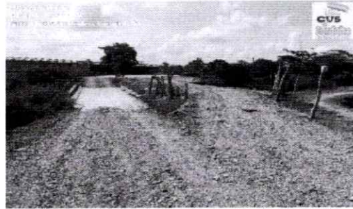
Foto 2. Obra antrópica puente de Boca de Catabre
