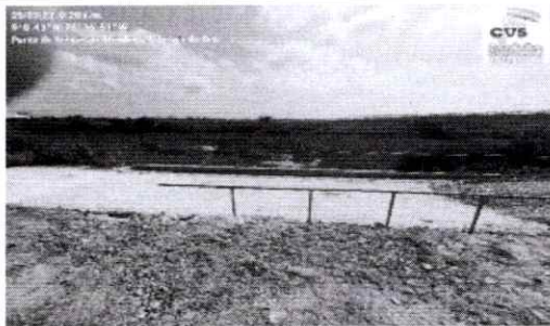
Foto 4. Obra antrópica puente de Boca de Catabre
