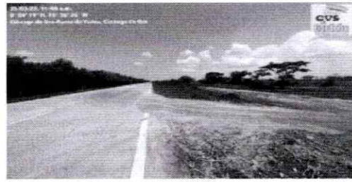
Foto 10. Sitio de presunta extracción de material de relleno utilizado
