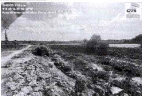
Foto 7. Obra antrópica puente de Boca de Catabre
