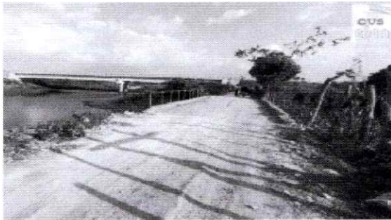
Foto 13. Puente de Boca de Catambre antes de la obra antrópica. 06/02/2023
