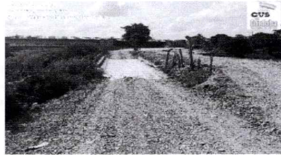
Foto 14. Puente de Boca de Catambre después de la obra antrópica. 25/03/2023
