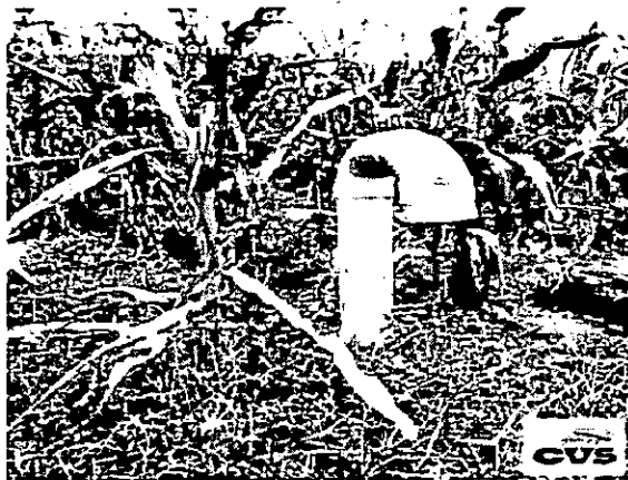
Foto 8. Chimenea de desfoque en el sitio.
