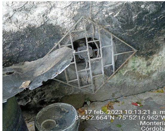
Foto 38. Extractor de emisiones en la cabina de pintura de vehículos
