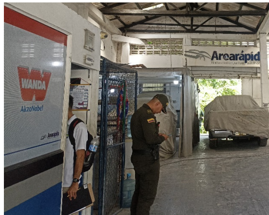
Foto 36. Cabina de pintura de vehículos en el sitio
