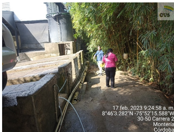
Foto 19. Vista posterior de cárcamos en el sitio
