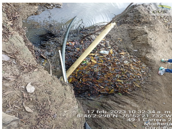
Foto 55. Tubería usada para captación de agua
