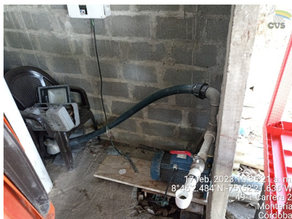
Foto 53. Motobomba usada para captación de agua
