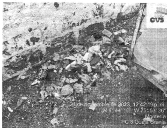
Foto 8. Presencia de residuos sólidos en el lugar.
