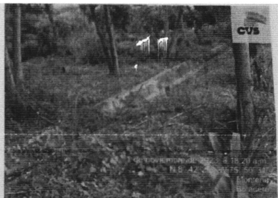
Foto 6. Canal perimetral en el sitio
