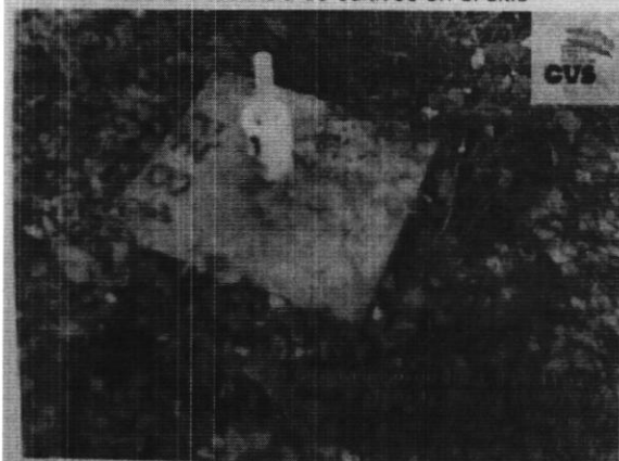
Foto 7. Pozo para estudio de agua subterránea de la Alcaldía de Montería
