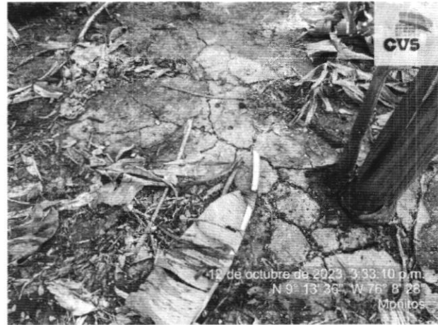
Foto 12. Placa de concreto presente en el predio..
