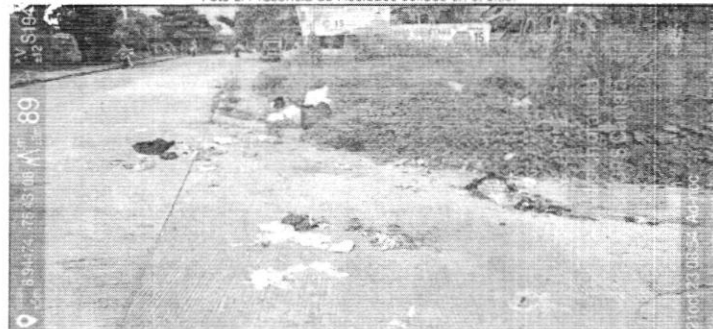
Foto 3. Presencia de Residuos sólidos en el sitio.
