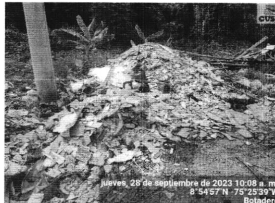
Foto 10. Presencia de RCD en el sitio.
