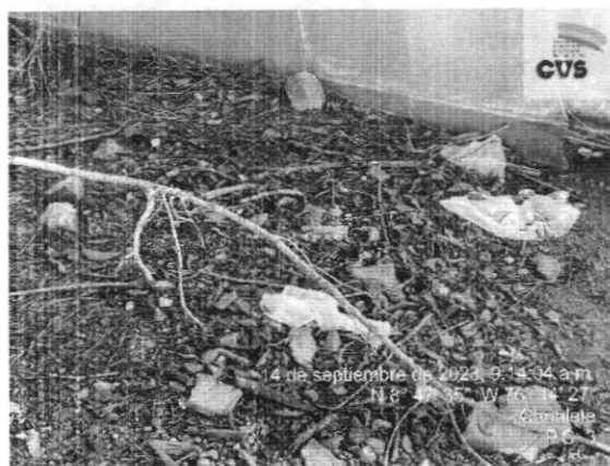
Foto 11. Aspecto general del sitio.
