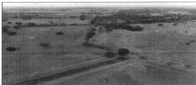
Foto 12. Fotografía aérea panorámica de la zona media donde se evidenciaron las actividades - Terraplenes, en la Finca El Floral, zona rural de Montería, jurisdicción del departamento de Córdoba.
