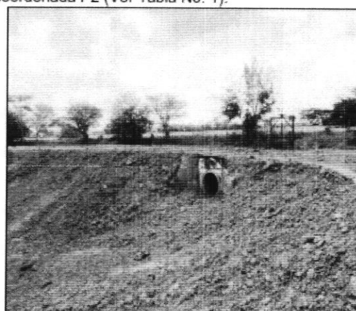
Foto 7 y 8. Punto final del recorrido hasta donde finaliza el canal de la finca El Floral y conecta con el canal El Poblado. Además, se evidencia una compuerta, la cual fue instalada por la CVS, según información del administrador de la finca.
