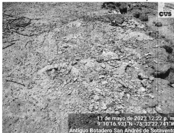
Foto 8. Presencia de RCD en el predio.
