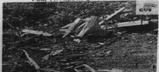
Foto 13. Presencia de RCD en el sitio.
