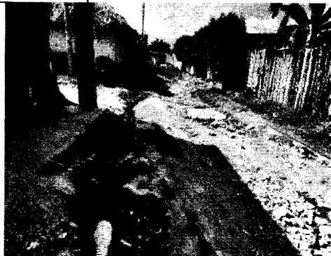
Foto 5. Las aguas residuales bajan por las calles sin pavimentar del barrio San Isidro.
