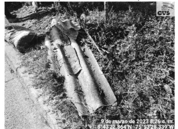
Foto 18. Disposición de residuos RCD
