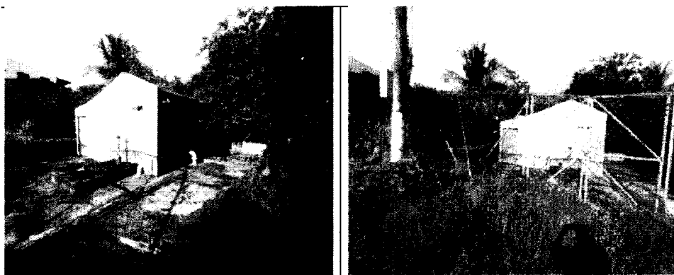
Estación de bombeo 1
