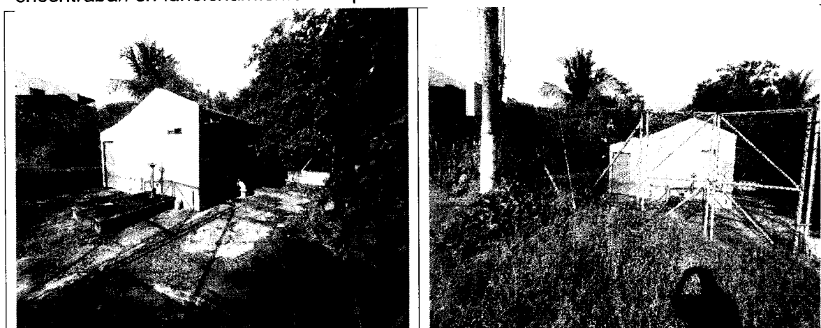
Estación de bombeo 1
