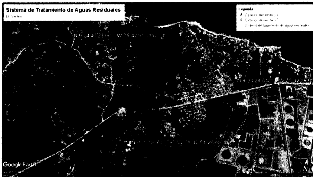
Imagen 2. Sistema de tratamiento de aguas residuales
