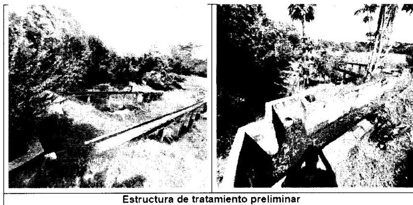
Estructura de tratamiento preliminar
