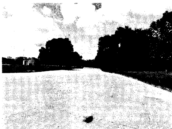
Foto 3: Construcción de vías asfaltadas
