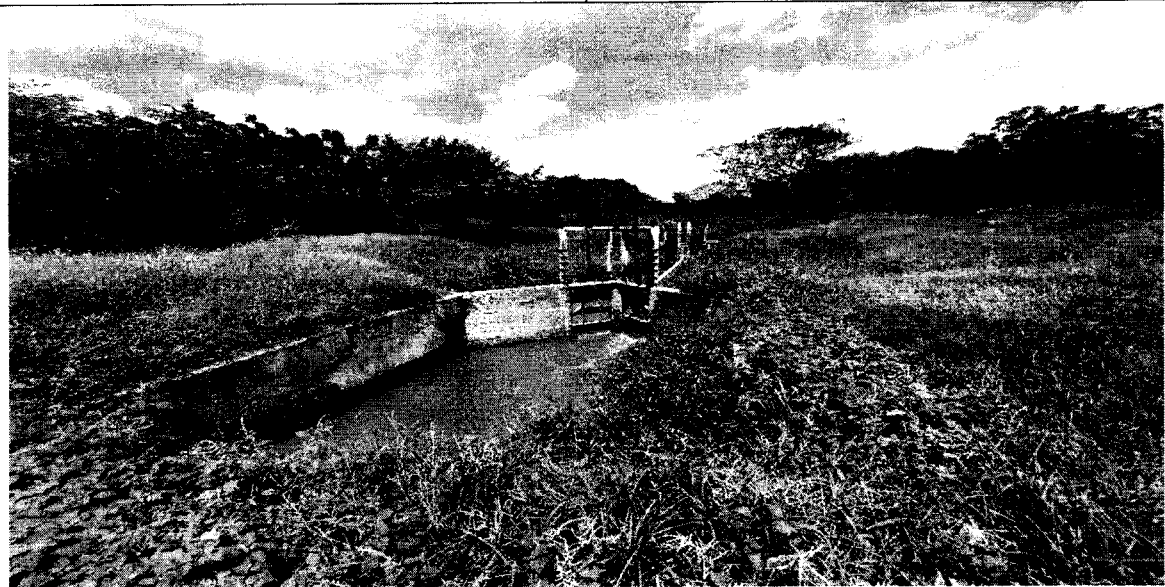
Estructura de tratamiento preliminar
