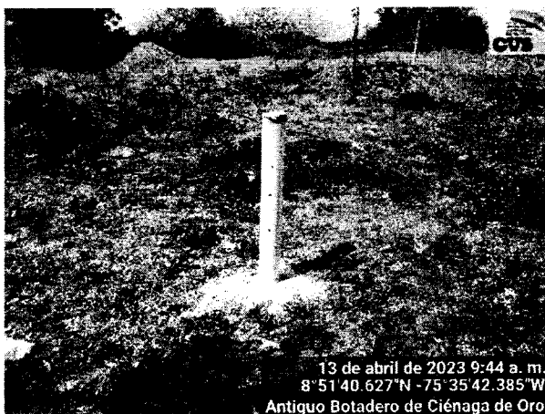
Foto 9. Chimenea de desfogue presente en el sitio.
