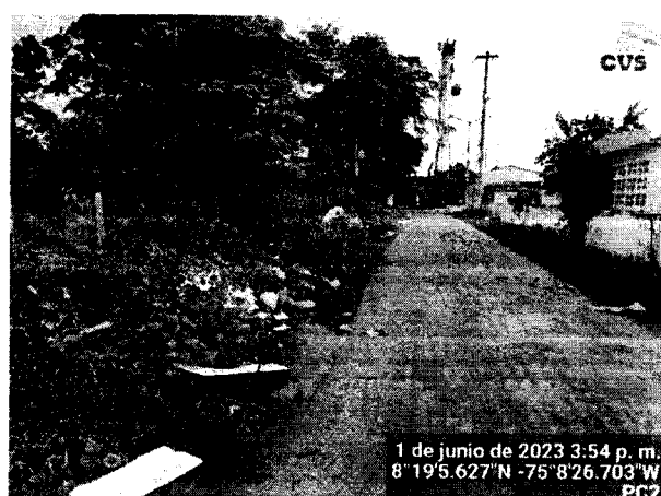
FOTO 12. Aspecto general del sitio.
